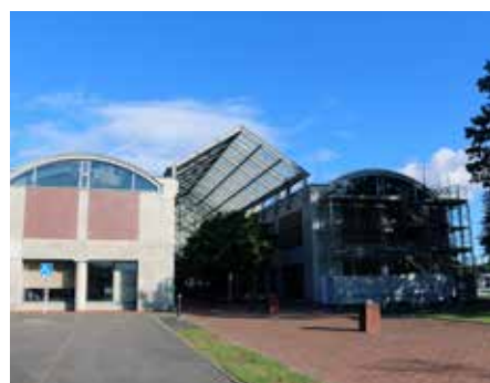
改修中の市民ホール
