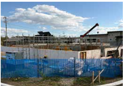
建設中の瓜幕自然体験留学センター
