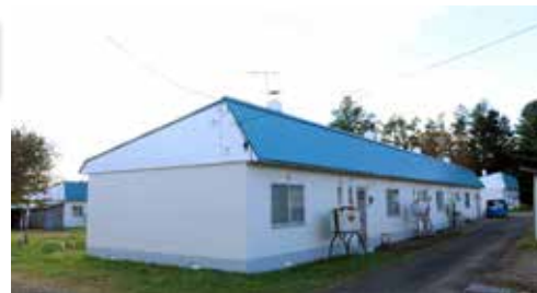
瓜幕西団地 残りの棟は令和8年度修繕中
