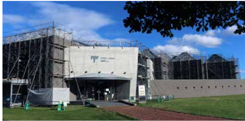
改修中の神田日勝記念美術館
