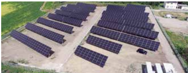
自営線ネットワークの太陽光発電と蓄電施設 東側に脱炭素先行地域事業で太陽光発電施設を設置予定
