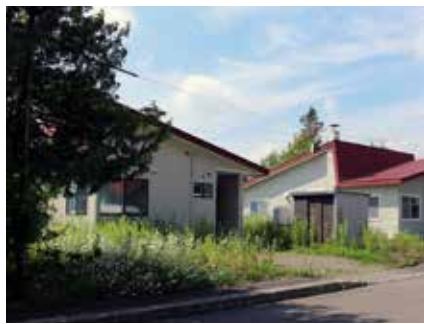
旧教員住宅（瓜幕東3） 保育園留学滞在用住宅に改修
