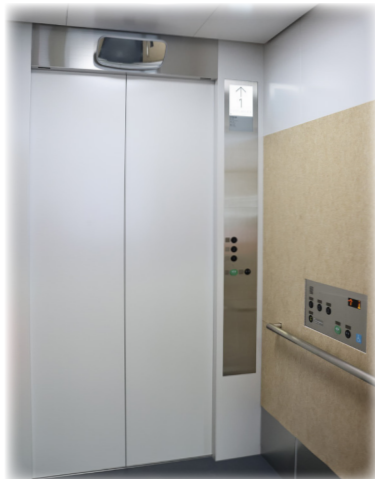
前後方向にドアがついている「2方向出入口タイプ」のエレベーターです
