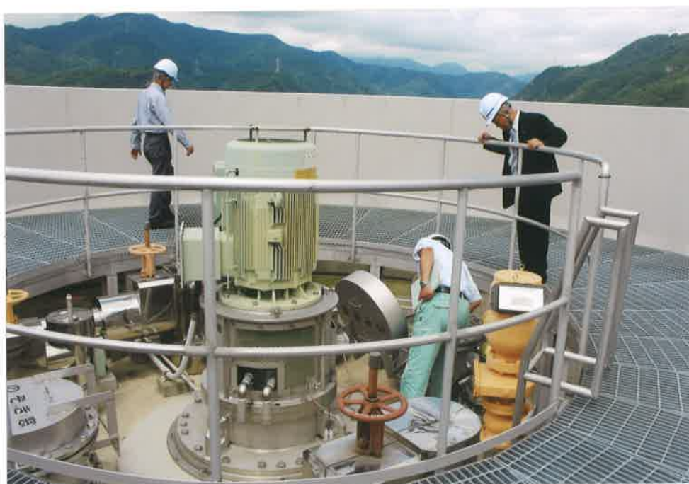
ガス発生装置
