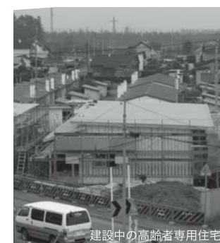
建設中の高齢者専用住宅
