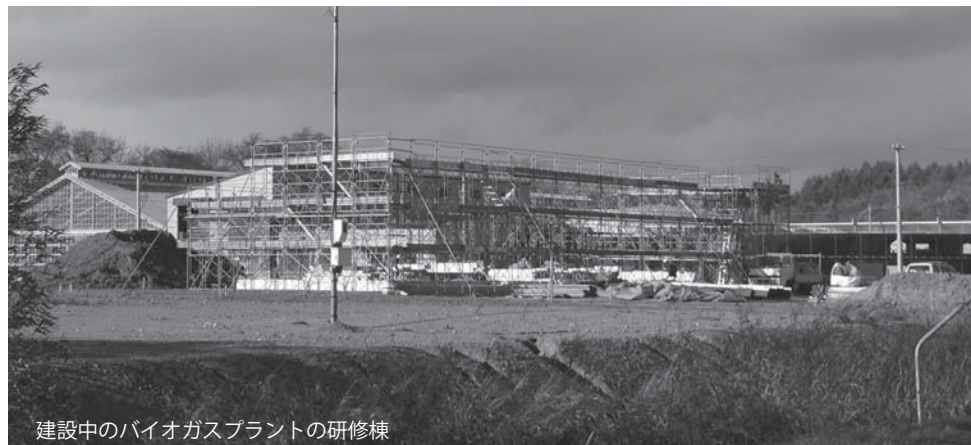
建設中のバイオガスプラントの研修棟
