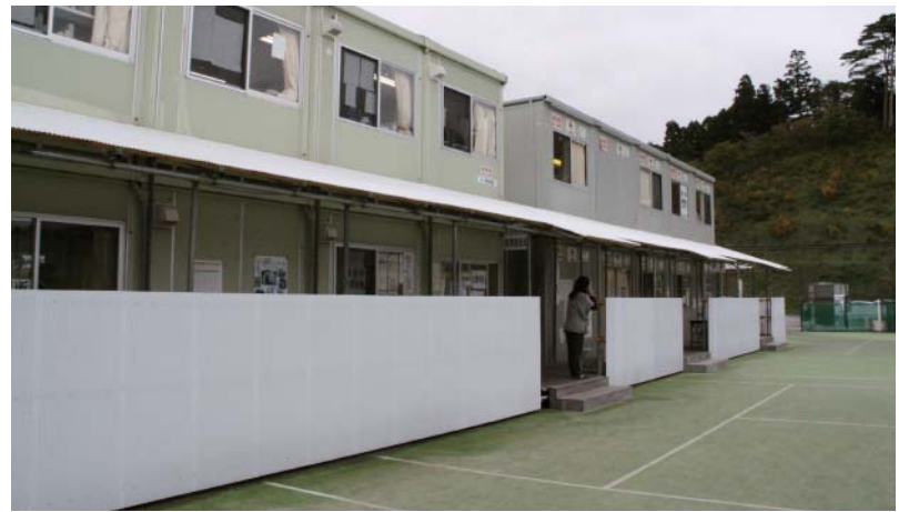
プレハブの南三陸町役場仮庁舎
