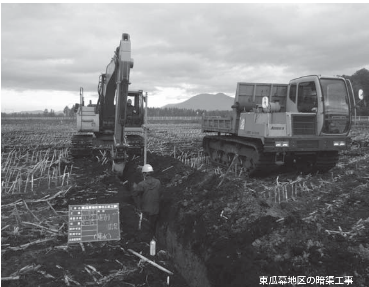
東瓜幕地区の暗渠工事
