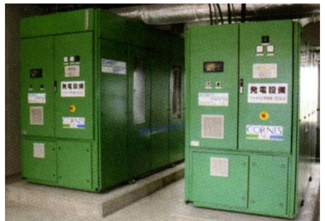
鹿追町環境保全センターのバイオガスプラント発電機
