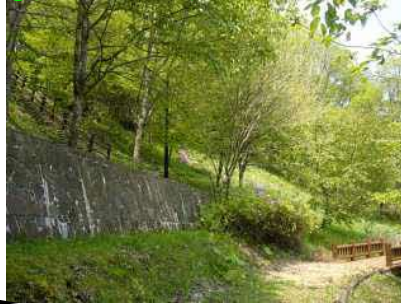
②歩道と治山施設
