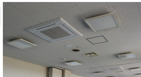
庁舎内各所に冷暖房設備を設置
