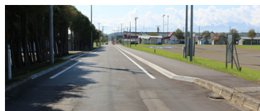
幅員工事により狭くなった道路
