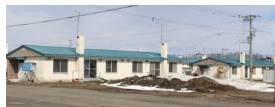
解体予定の白樺団地(北町)
