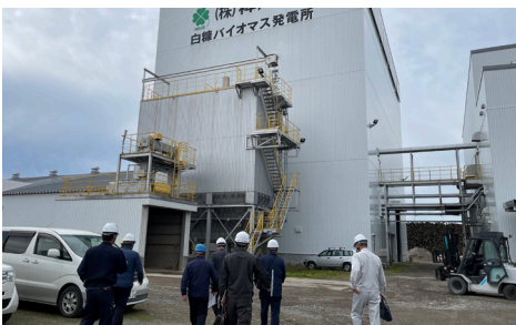
神戸物産バイオマス発電所 主に間伐材を燃料として使用
