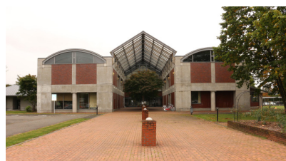
大規模改修が行われる町民ホール
