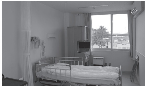
病室他にスプリンクラーを設置
