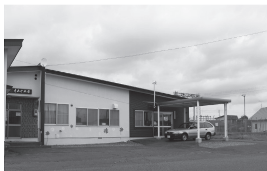
もみじ工場の東隣（右奥）に作業所を設置
