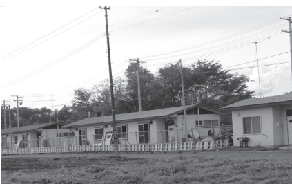
解体が進む新生団地
