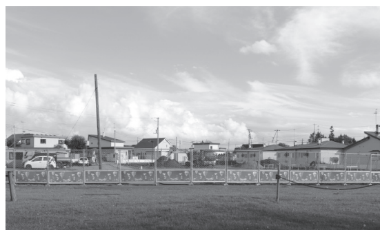
工事が進む鹿追高校寄宿舎建設現場
