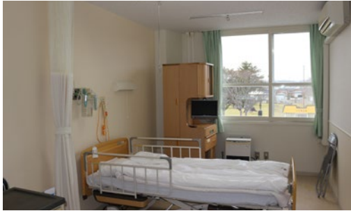
病室他にスプリンクラーを設置
