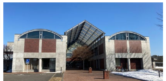
町民ホール 自営線ネットワーク内の公共施設改修を検討
