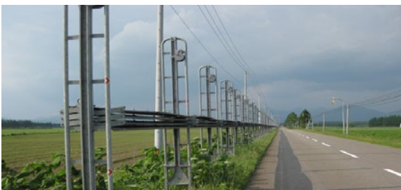
町道7号線の防雪柵 支柱が折り畳まれていない
