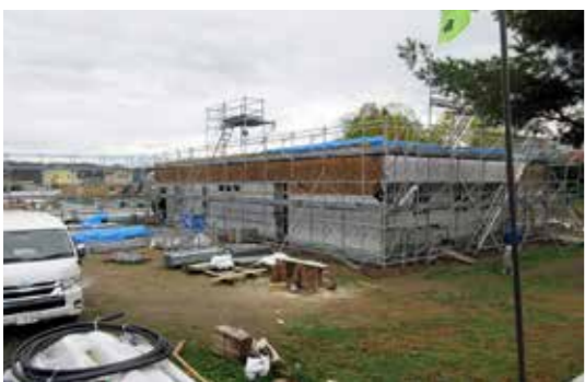
建設中の大空高校新寮 (R4.10.4)
