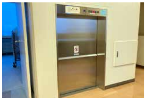
役場庁舎内の小荷物専用昇降機の場所にエレベーター設置を検討
