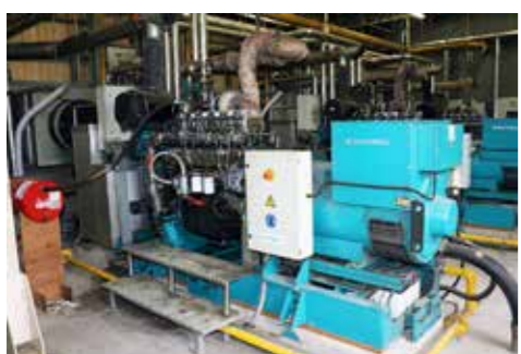
瓜幕バイオガスの発電機 発電時の余熱で水耕栽培ハウスでトマト等を栽培
