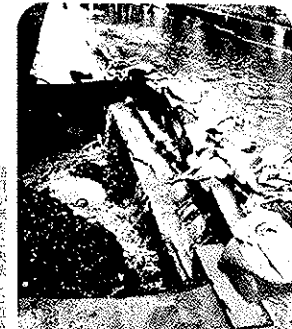
路肩が崩壊して決壊した道路 (8月6日午前6時20分 窪道橋)
