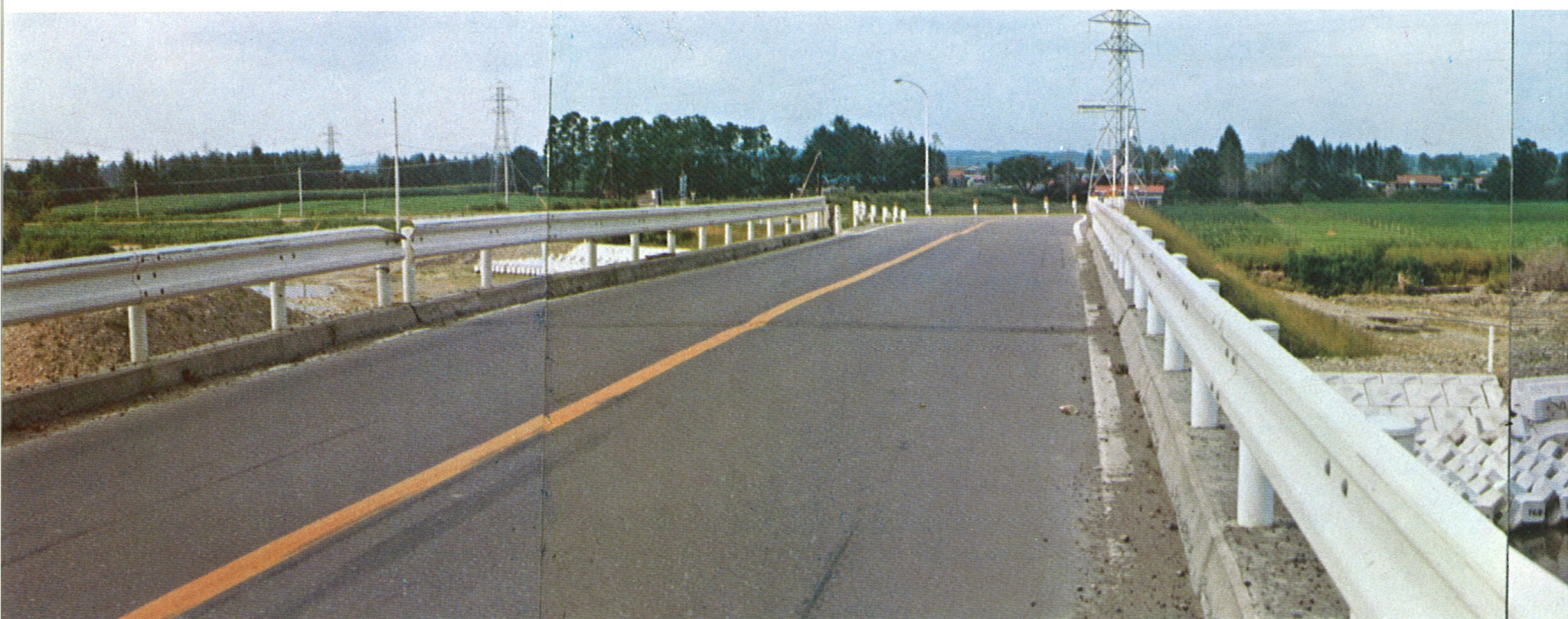
復旧工事中の鹿追橋とその周辺
