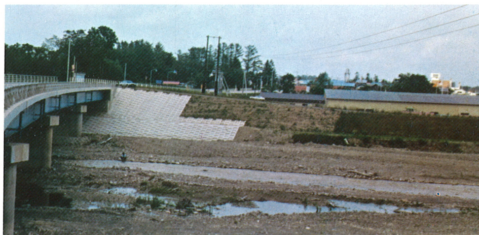
復旧工事の進む万代橋右岸
