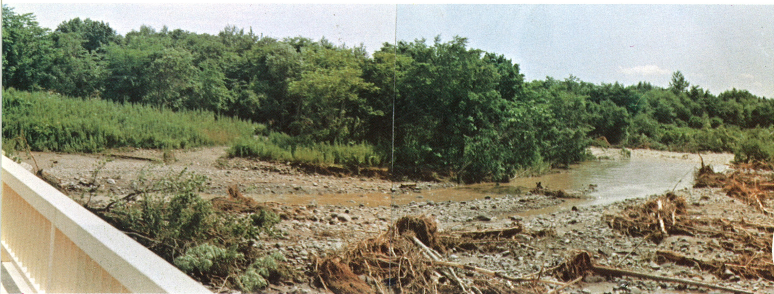
災害直後の然別川の惨状（瓜幕橋から下流を見る）
