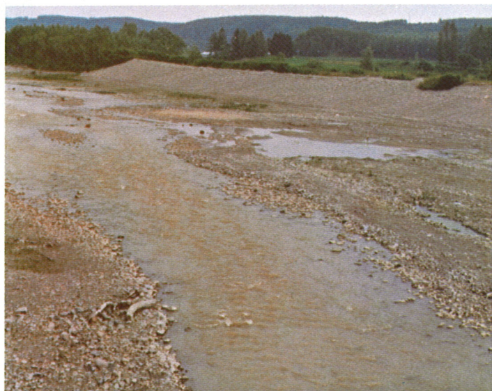
復旧工事の進む万代橋付近右岸 写真中央の頭首工も破壊される
