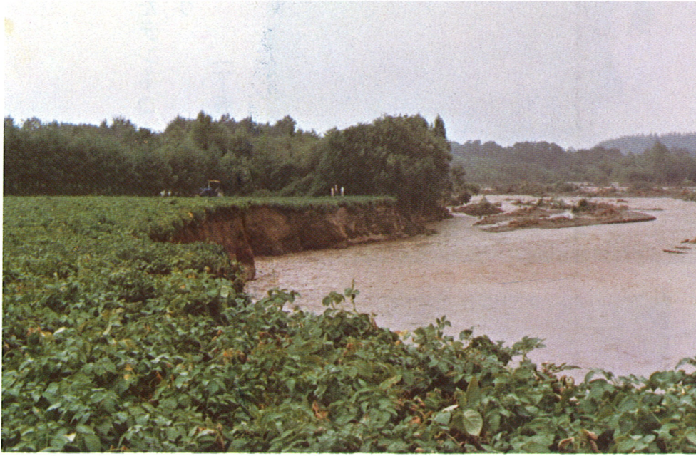
畑を侵して川幅を広げた然別川 (上然別地区)
