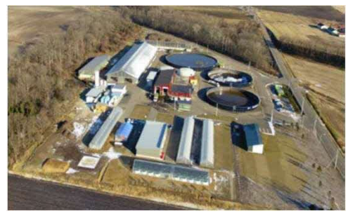
中鹿追バイオガスプラント
