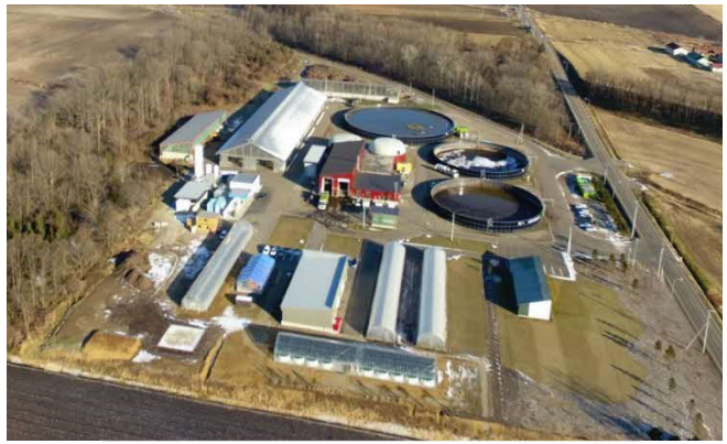
図9 中鹿追バイオガスプラントの状況
