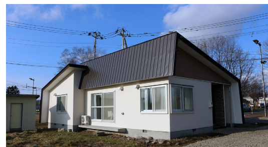
教育支援センター トリムセンター南側に設置
