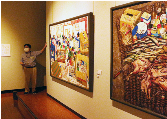
神田日勝記念美術館 雨漏り対策で仮壁を設置
