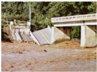
崩壊した紅葉橋
