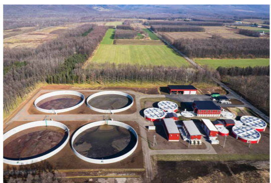
→ 瓜蓑バイオガスプラント
