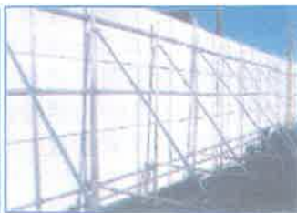
【仮囲いの設置】
