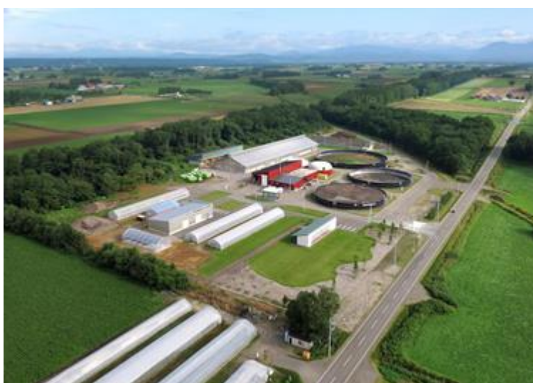
中鹿追バイオガスプラント全景
