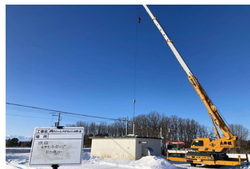
取水ポンプ更新工事の様子
