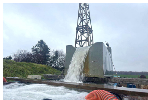
水源地新設工事の様子
